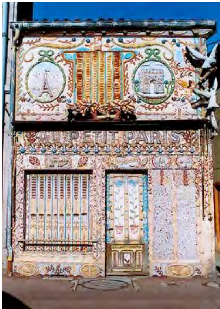
Annexe 1.22 : Le Petit Paris de Marcel Dhièvre, à Saint Dizier (Haute-Marne)
